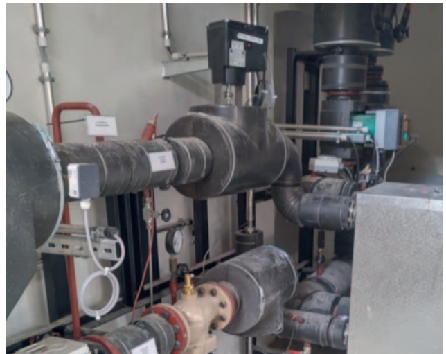
33: Fernwärmeübergabestation im hessischen Landtag
