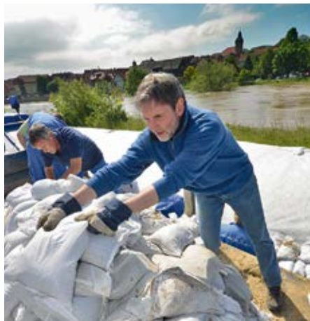
Werra-Hochwasser: Sandsäcke sollen im Juni 2013 den Deich bei Witzhausen schützen.
