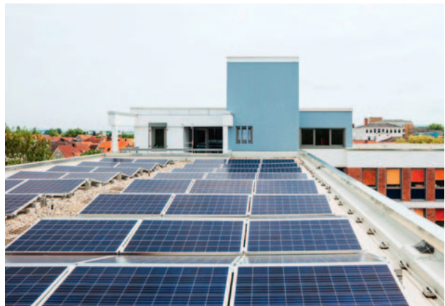
Modulreihen in Ost-West Ausrichtung
