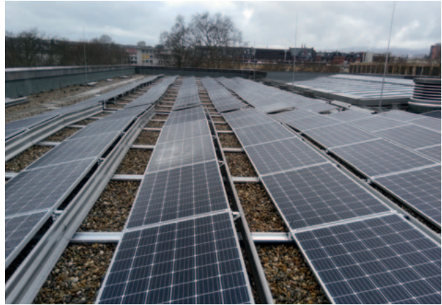
Modulreihen in Südausrichtung
