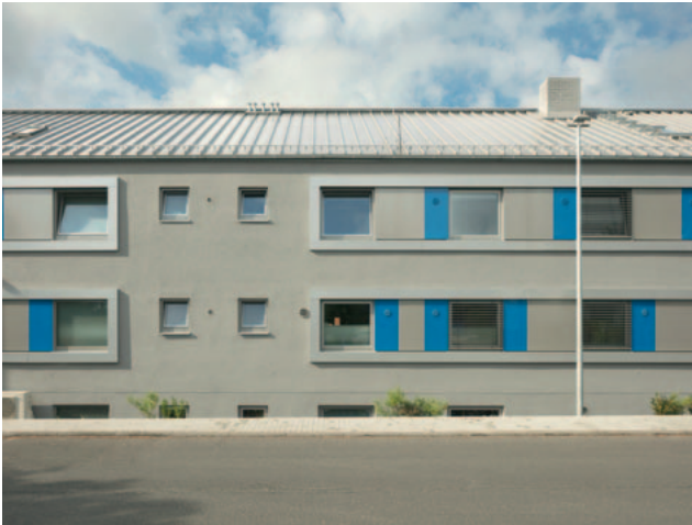
Gebäude nach der Sanierung
