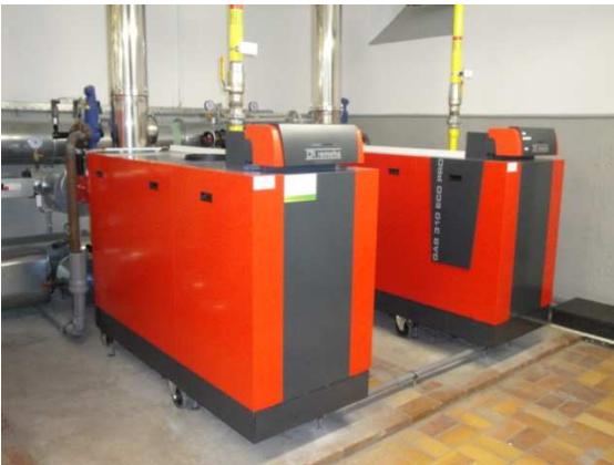
Gas-Brennwertkessel
