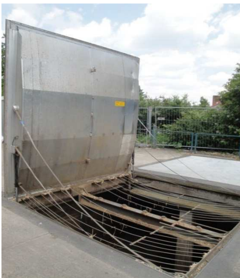
Unterirdisches Hackschnitzellager
