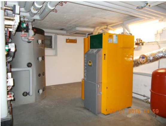
Pellet Heizkesselanlage
