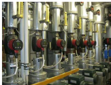
Modernisierung Nahwärmenetz / Hocheffiziente Pumpen / neues BHKW
