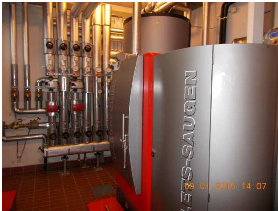
Pellet Heizkesselanlage
