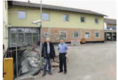
Sanierung bei laufendem Betrieb: Geduld der Mitarbeiter ist gefordert
